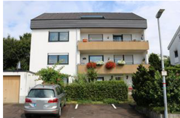
Abb. 21: Hausansicht (Blick in nördliche Richtung)
