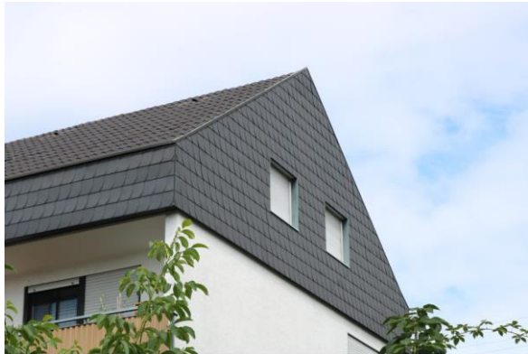
Abb. 20: Dachansicht (Blick in nordwestliche Richtung)
